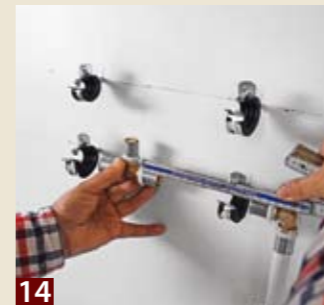
10 Musterinstallation: Wir beginnen beispielsweise einmal mit einer Wandhalterung für die beiden Waschbecken-Absperrventile.
