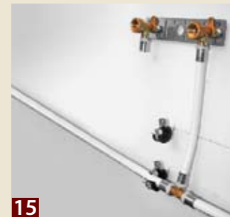
11 Bei einzelnen Anschlüssen – etwa für WC-Druckspüler oder Urinal – diese auf einer Horizontalen an der Wand verschrauben.
