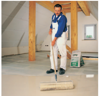
Mit der Stachelwalze wird eine besonders ebene Oberfläche erzielt
