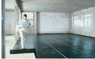
Knauf Abdichtungsbahn Katja Sprint schützt den Boden vor Feuchtigkeit bei erdreichberührten Böden
