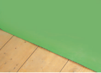
Knauf Schrenzlage als Rieselschutz auf Holzbalkendecken
