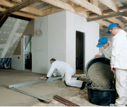
Knauf EPO-Leicht: Der begehbare Ausgleich mit geringstem Gewicht (2 kg/m 2 je cm Schichtdicke)
