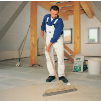
Knauf Nivellierspachtel 415 ist spannungsarm und ideal zum Spachteln von Fertigteil ESTRICHEN
