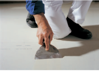
Plattenstöße mit Knauf Uniflott/TRIAS schließen
